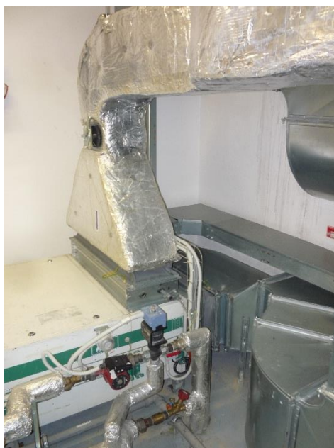
Stávající stav – pohled do prostoru za VZT jednotkou. / Stávající periferie MaR a čerpadlo na větvi teplé vody.
